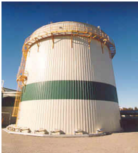
Εικ. 6: Αναερόβια δεξαμενή ζύμωσης στερεών αποβλήτων για παραγωγή ενέργειας
